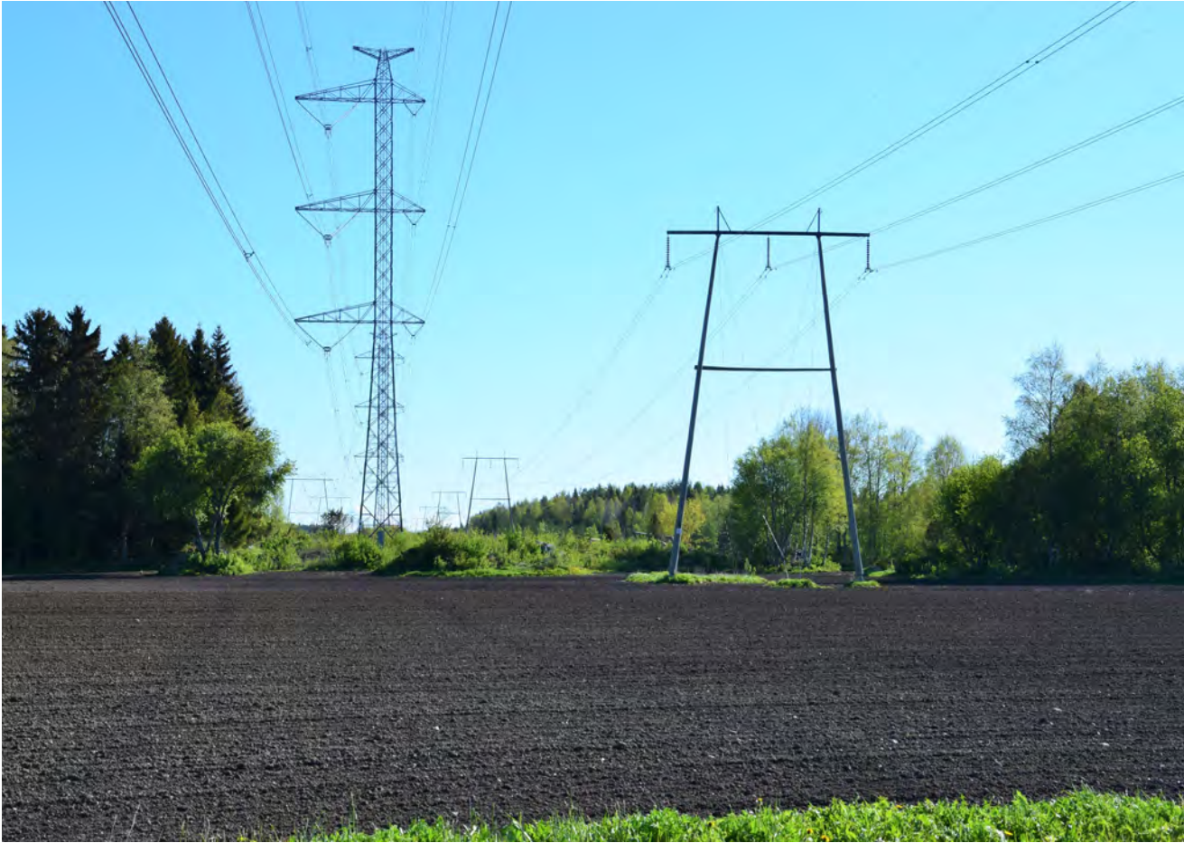
Voimajohtokäytävä. Kuva: Christine Bonn.
